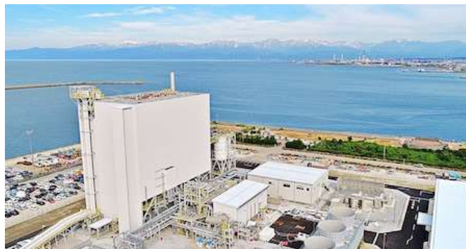
写真-3 プロジェクト BE-01 伏木万葉埠頭バイオマス発電所
